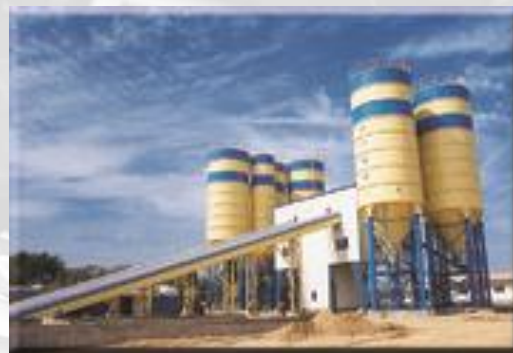
Ленточный бетонный завод
